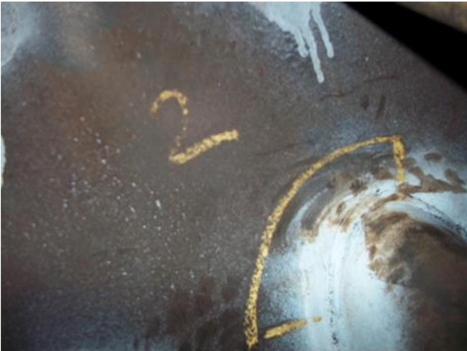
Stutzen 3 ist die Gaspindelverbindung des Tanks (ebenfalls mit dem internen Rohrleitungssystem verbunden) und weist, wie unten dargestellt, einen 50 mm langen Riss auf:
