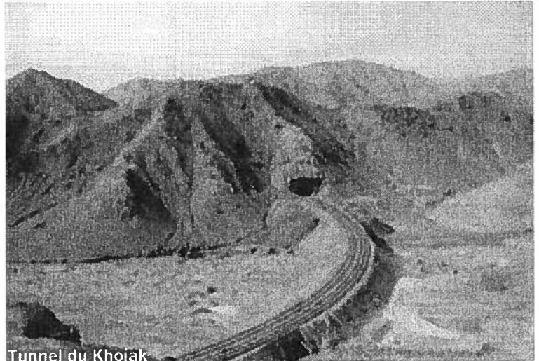
Tunnel du Khojak
